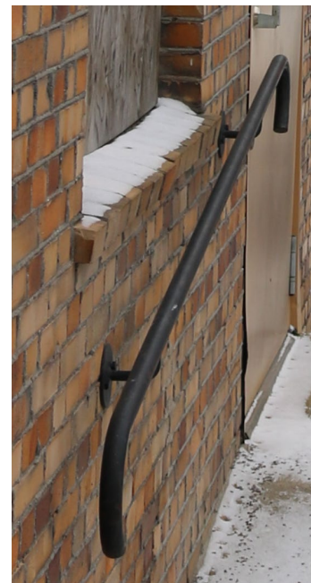
Figur 20. Enkel handledare i svart smide, på baksidan av den brandskadade byggnaden.
