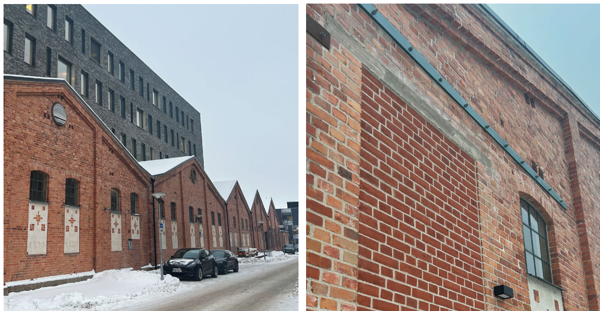
Figur 28. Äldre industribyggnader lagade och kompletterade med återbrukat tegel. Äldre tegelmur integrerad i ny bebyggelse, samt lagning och komplettering med återbrukat tegel. Kopparlunden, Västerås. Foto Norconsult
