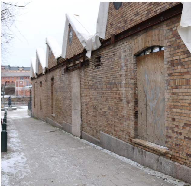
Figur 23. Den tidigare bygganden har en låg trappande sockel av sten och genom höjd- och fönstersättning en god kontakt mellan gaturum och interiör. Sockeln markeras i orange i bilden till höger.
