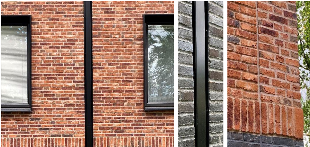
Figur 15. Referensbilder på samtida tolkning av detaljering och hantering av skarvar i byggelement med infällt stuprör (till vänster, mitten) och som markering av byggnadens hörn. Studentbostäder Östra Källtorp, Göteborg, av Liljewall arkitekter, foto Mikael Hammerman.
