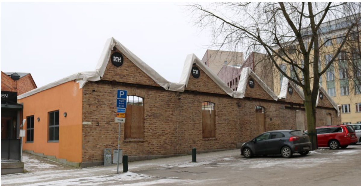
Figur 1. Ruinen av den brandhärjade byggnaden inom kvarteret Vävstolen, sett från Korsgatan, februari 2022.
