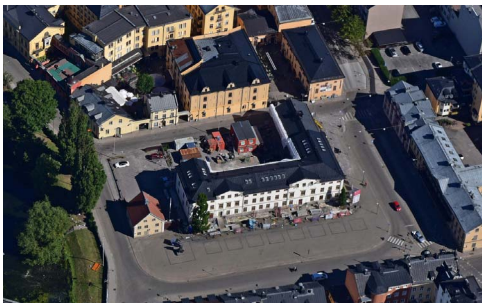
Bilden visar planområdet med befintliga byggnader mitt i bild, med pågående renovering av det Eschelonska huset. Norrköpings kommun, 2016.
