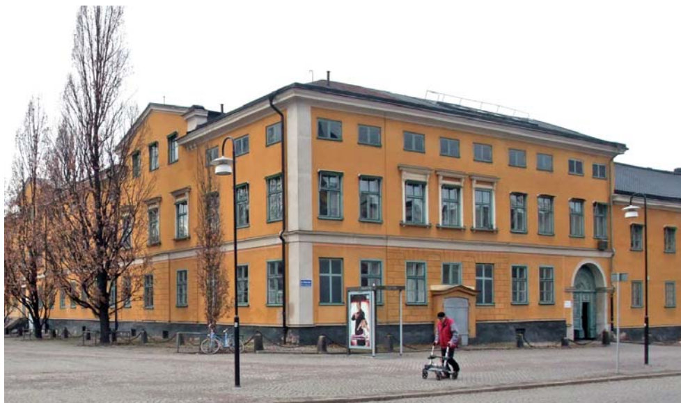
Eschelonska huset innan renovering. På bilden ser vi både den södra och östra delen av bebyggelsen. Till höger är portingången som leder in till innergården och på andra våningen ser vi fönstren med överliggare.
