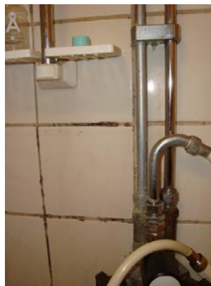
Mikrobiell tillväxt i fogar
