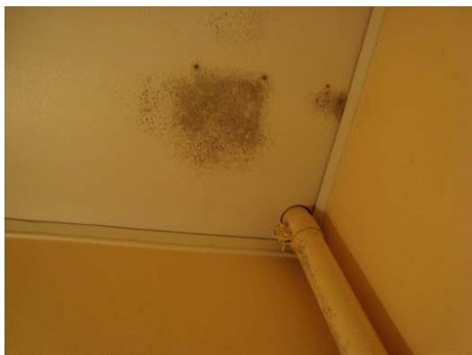
Mikrobiell tillväxt i tak
