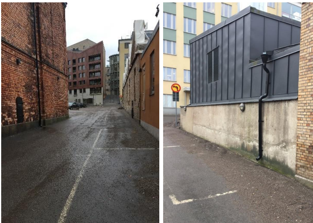
Figur 10 Vänstra bilden: Västra Grytsgatan. Högra bilden: Stuprör från tillbyggnaden
