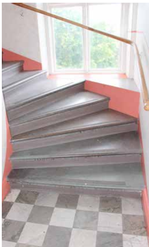
Trapphus med stengolv i ruttmönster
