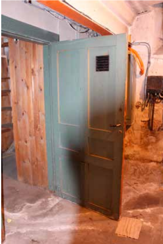
Dörr i källaren
