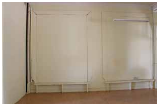
Igensatta öppningar in till den tidigare resegodsexpeditionen.
