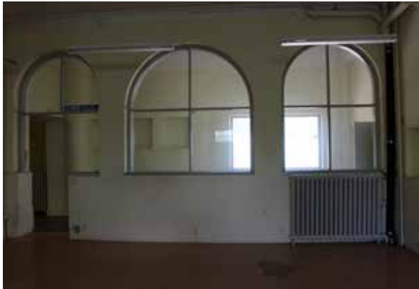
Bågformade fönster i mellanvägg.
