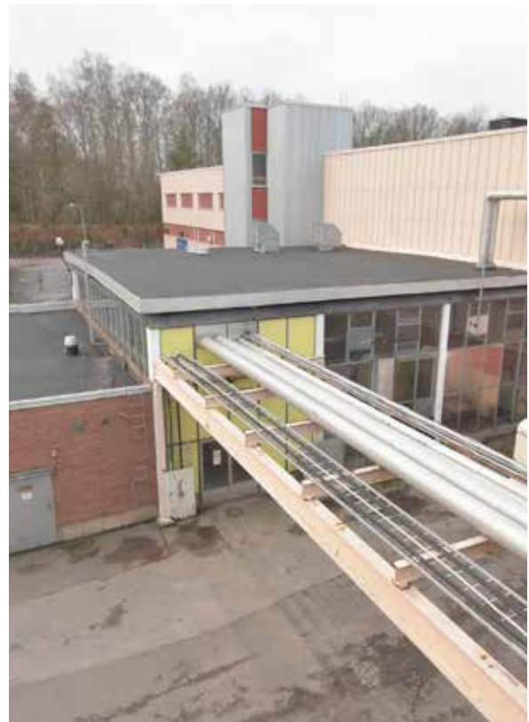
Panncentralbyggnaden bevarar sitt ursprungliga utseende.
