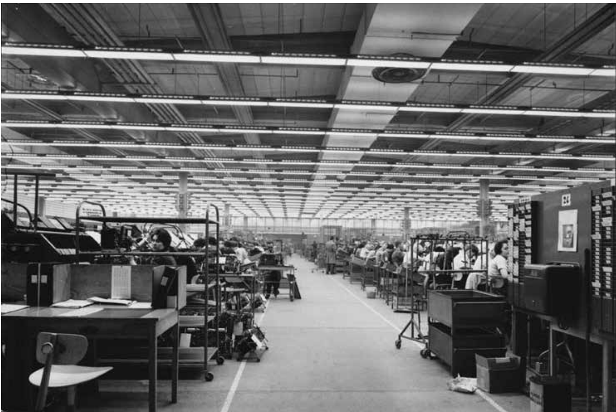
Interiörbild, troligen från 1980-talet, efter att taklanterninerna rivits.
