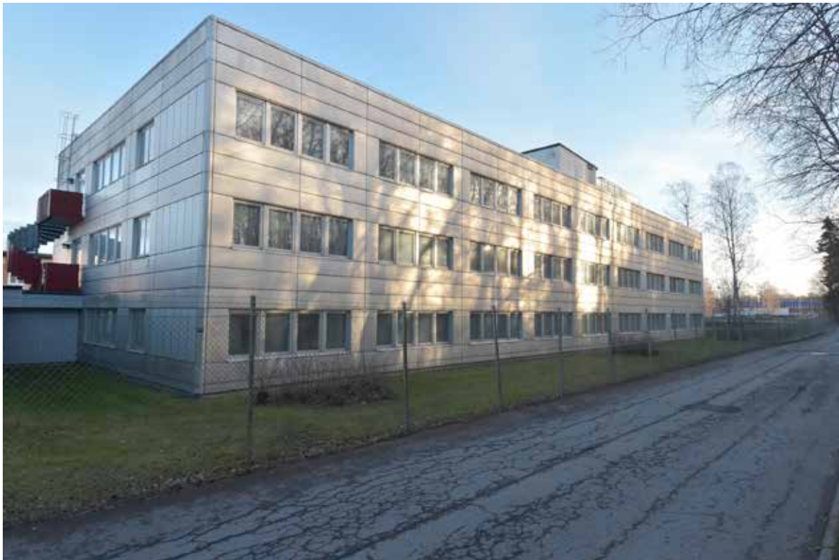
Kontorsbyggnad 3 sedd från Lundatorpsvägen.
