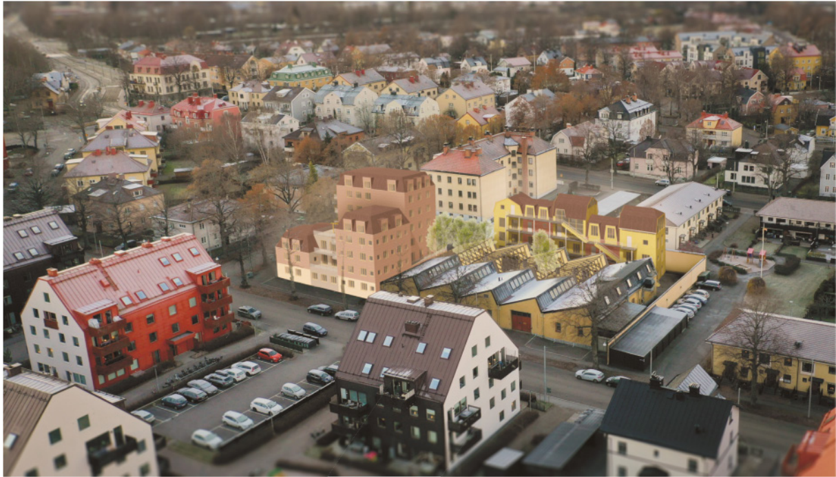
Översiktbild som visar del av byggnad där stomme friläggs.
