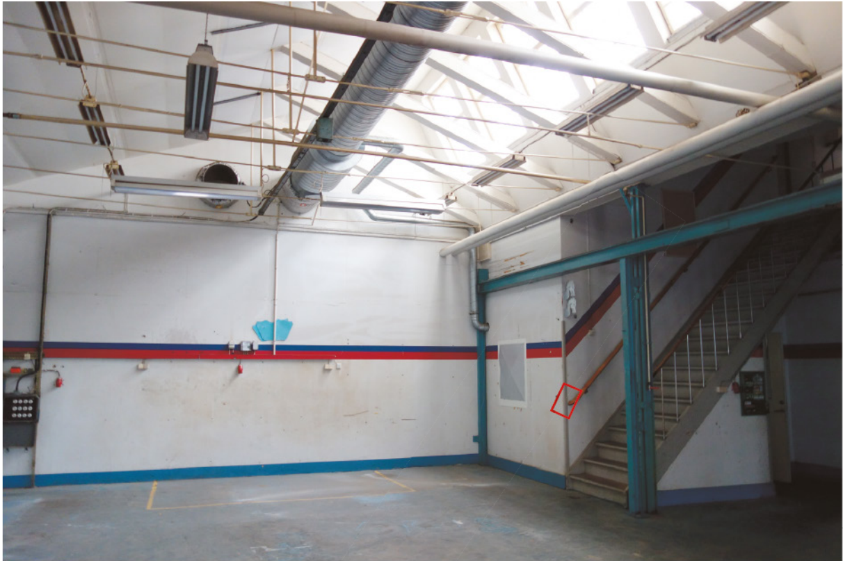
Den underpända takstols konstruktionen som den ser ut idag.
