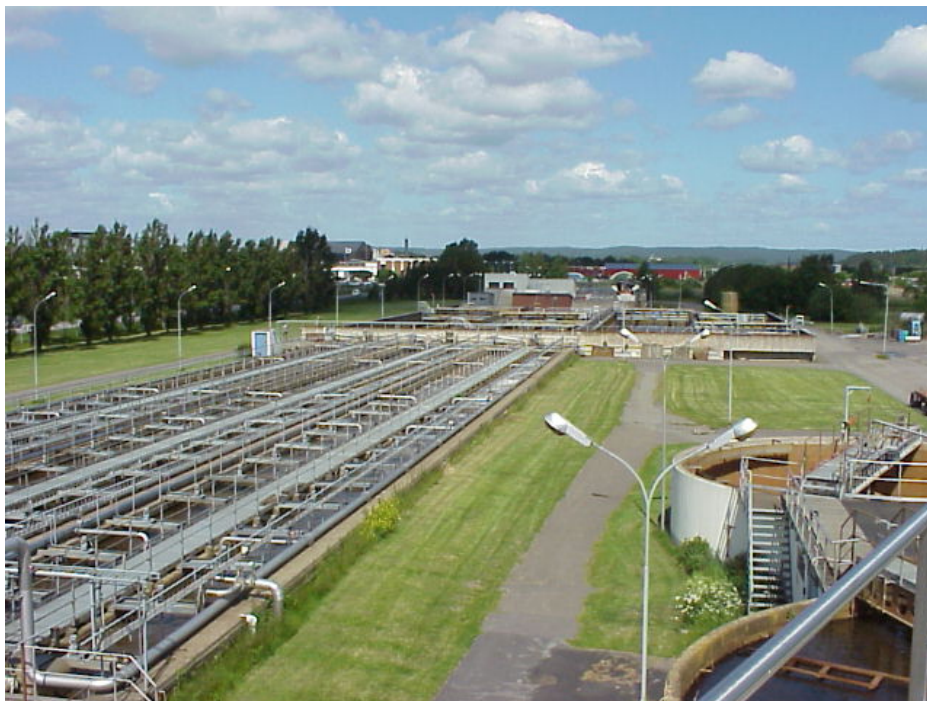
Vy över delar av Slottshagens avloppsreningsverk, Norrköping.
