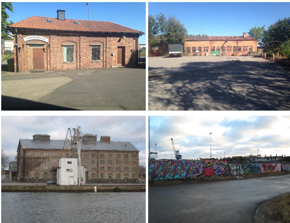
Figur 5 Överst: Det gamla gasmästarkontoret samt det gamla apparathuset på gasverkstomten. I förgrunden till apparathuset syns platsen där den tidigare gasklockan legat. Nederst: Andreas kvarn samt graffitiväggen.
