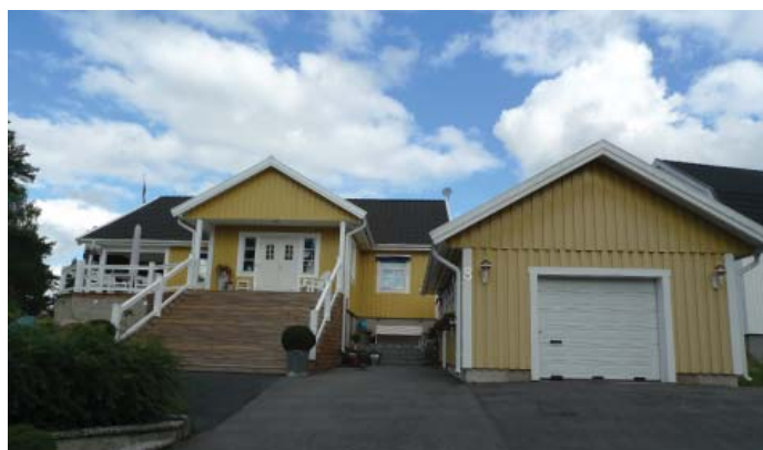
Nybyggnation längs Skogvallavägen
