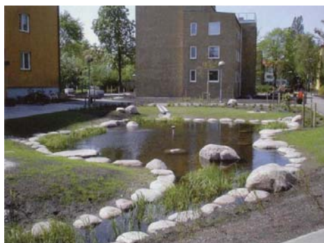
Exempel på utformning av dagvattendamm.
